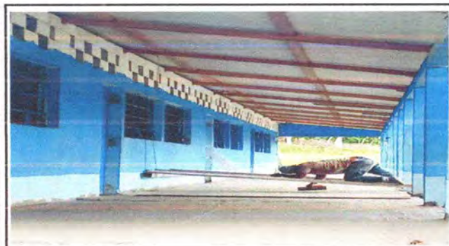
Foto 3: Colocacion de piso entorata
