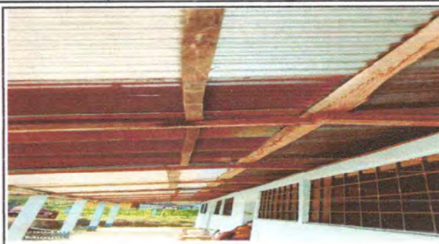
Foto 2: Cambio de laminas
