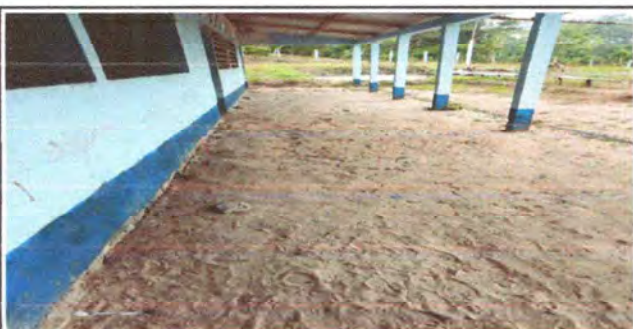
Foto 5: Colocacion de ventanas
