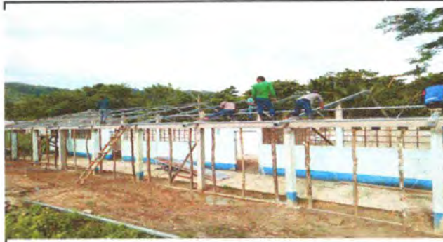
Colocacion de vigas de metal.
