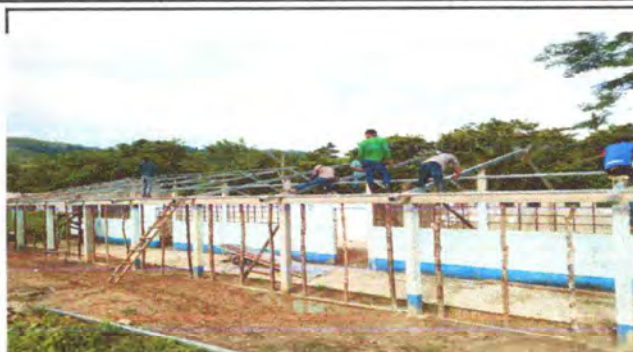
Foto 2: Cambio de laminas
