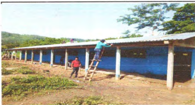
Colocacion de laminas
