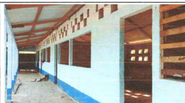
Foto 4: Colocacion de puertas
