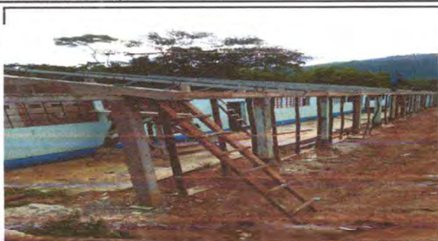
Foto 1: Cambio de costanera de madera a metal.
