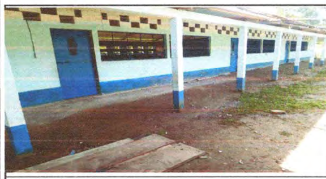
Foto 5: Colocacion de puertas
