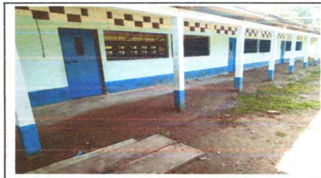
Foto 4: Colocacion de puertas
