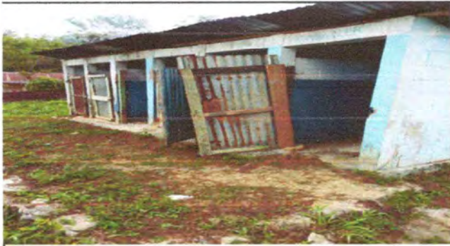
Foto 1: Cambio de puertas y techo de baños
