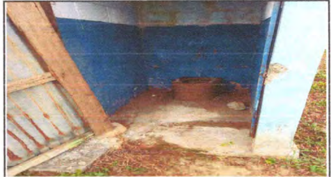
Foto 2: Cambio de losa
