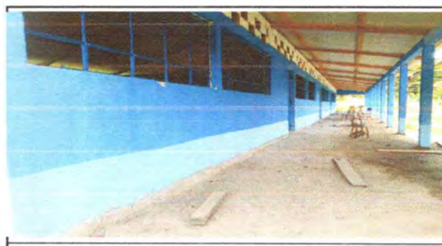
Foto 6: Cambio de ventanas
