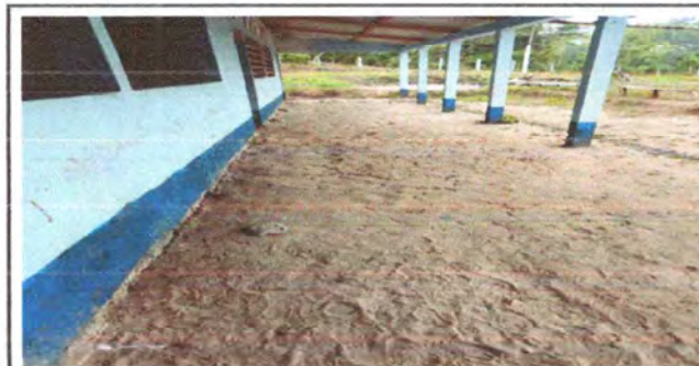
Foto 5: Colocacio de piso entortada en el corredor
