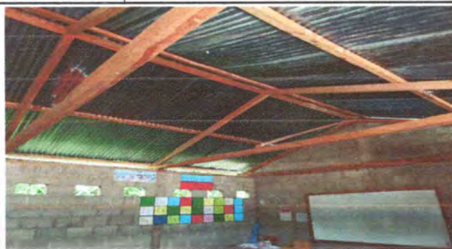
Foto1: Cambio de costanera de madera a metal.
