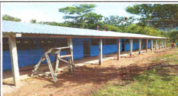
Foto 6: Colocacion de capoteras.
