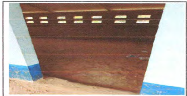
Foto 6: Colocacion de puertas
